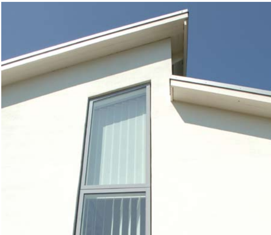
De två yttre takplanen möts inte i nocken utan ger plats för en fönsterpanel som går att öppna och som jämnar ut rumstemperaturen varma sommar dagar.
